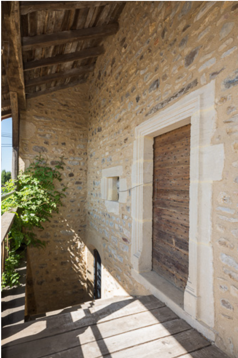
Vue de la galerie, protégée par un débord de toit soutenu par le dépassement des murs-pignons
