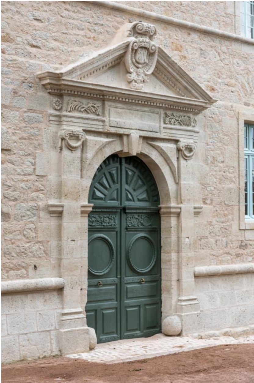
Façade nord-est, portail portant la date de 1652.
