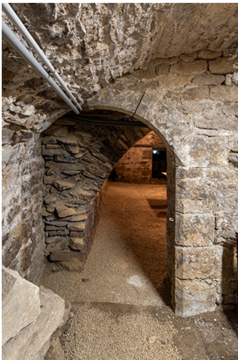
L'entrée de la cave située sous la demeure.
