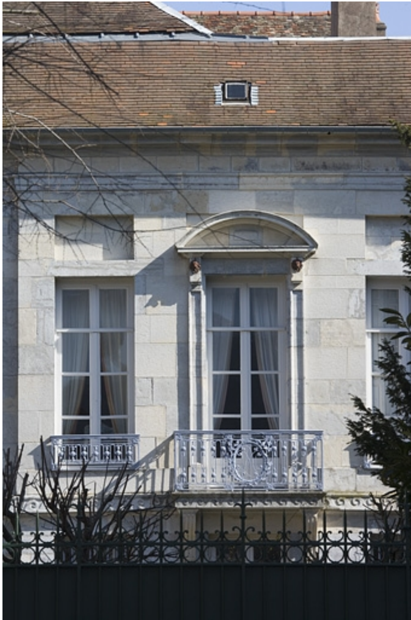
Hôtel en fond de cour : détail de la fenêtre centrale, premier étage sur jardin.
