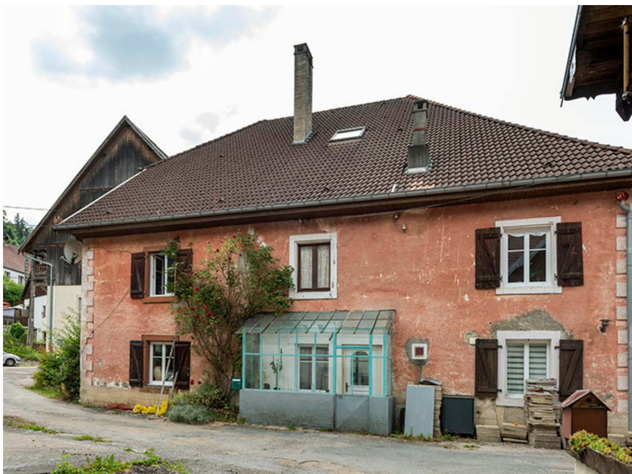
Maison : façade est (côté cour).
