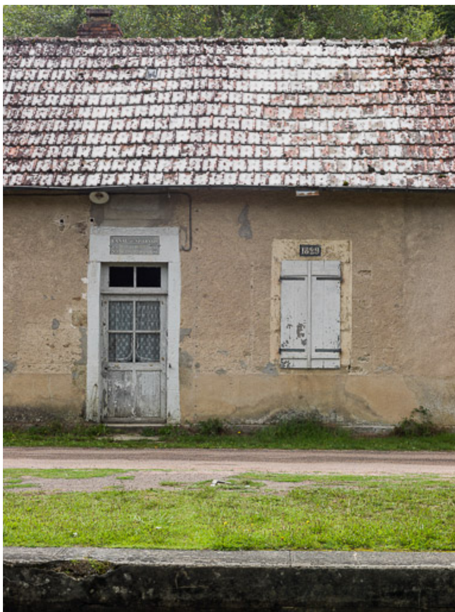
Détail des ouvertures de la maison éclusière.
