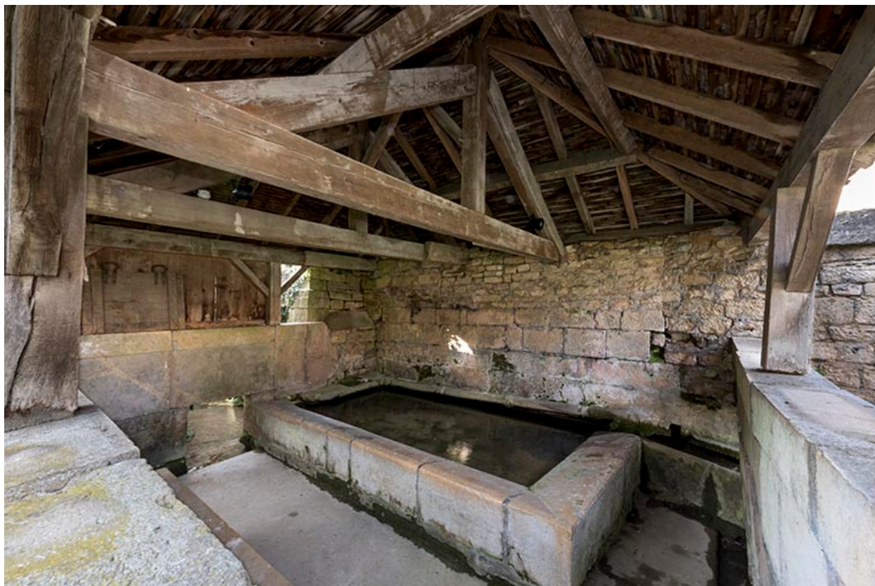
Fontaine-lavoir, 1 rue du Pâquis : intérieur du lavoir.
