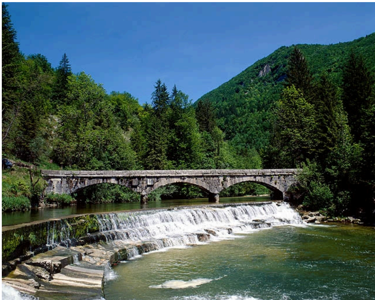
Vue générale depuis l'aval.
