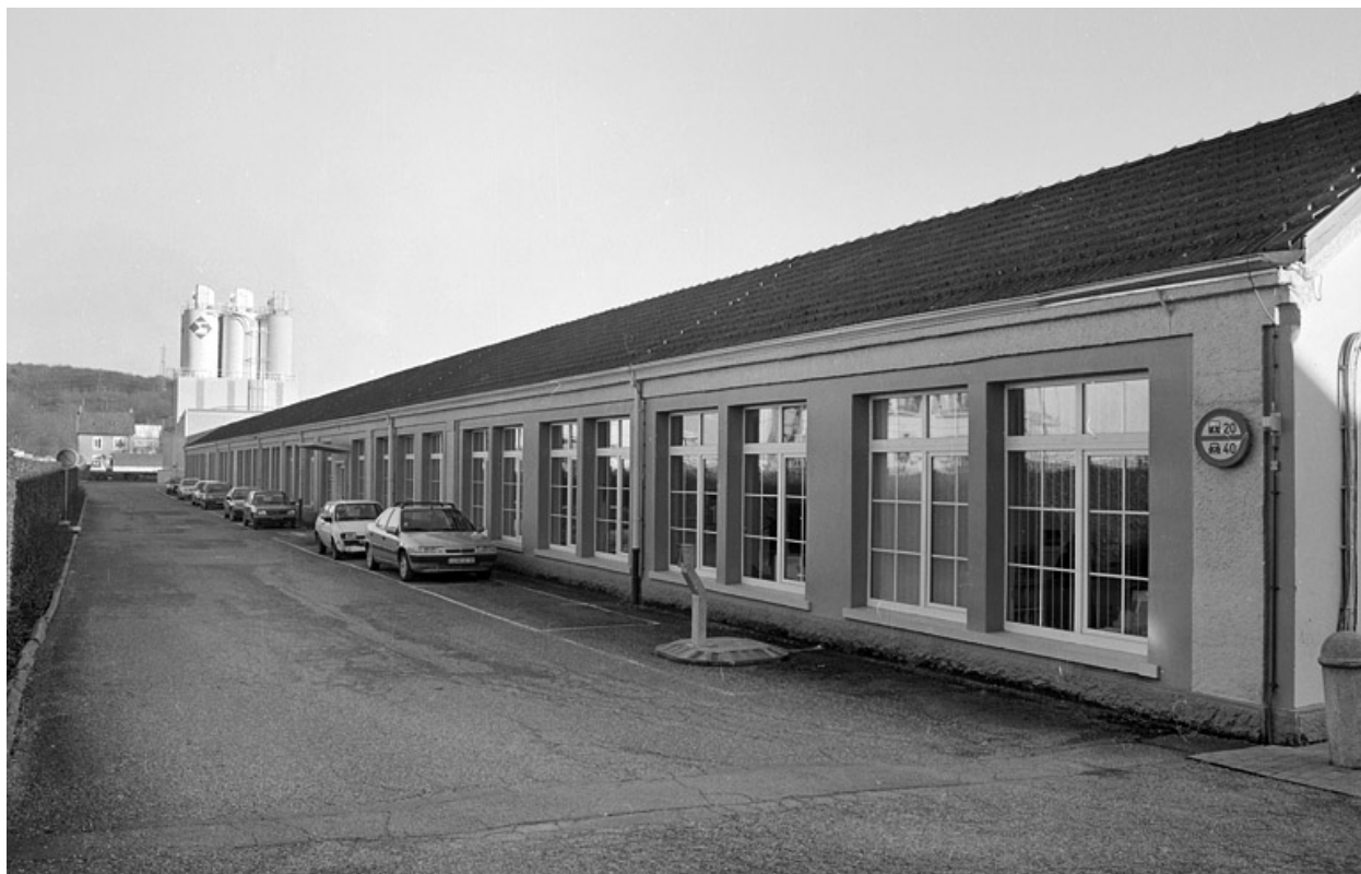
Façade nord de l'atelier de fabrication.
