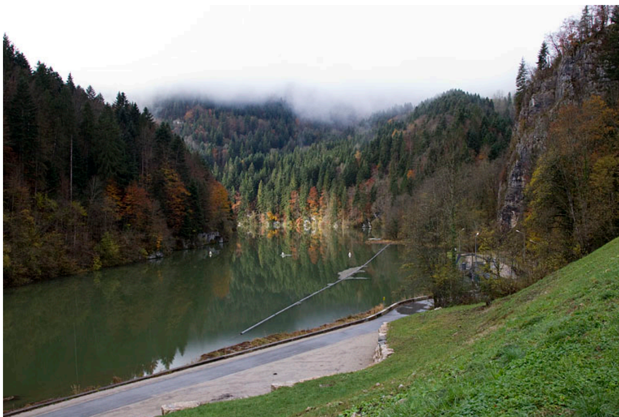
Barrage du Refrain (communes de Fournet-Blancheroche, France, et des Bois, Suisse) : la retenue de Biaufond vue du barrage.
