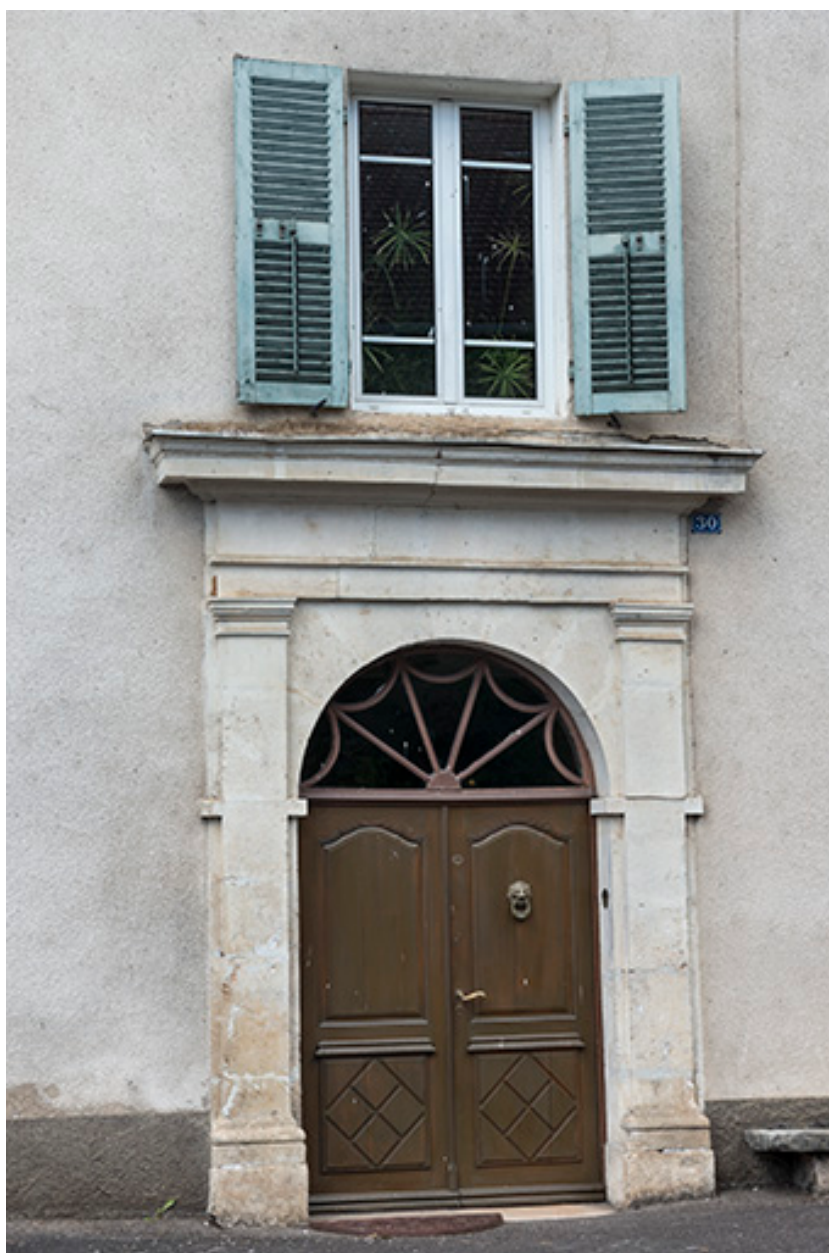
Façade antérieure : détail de la porte d'entrée.
