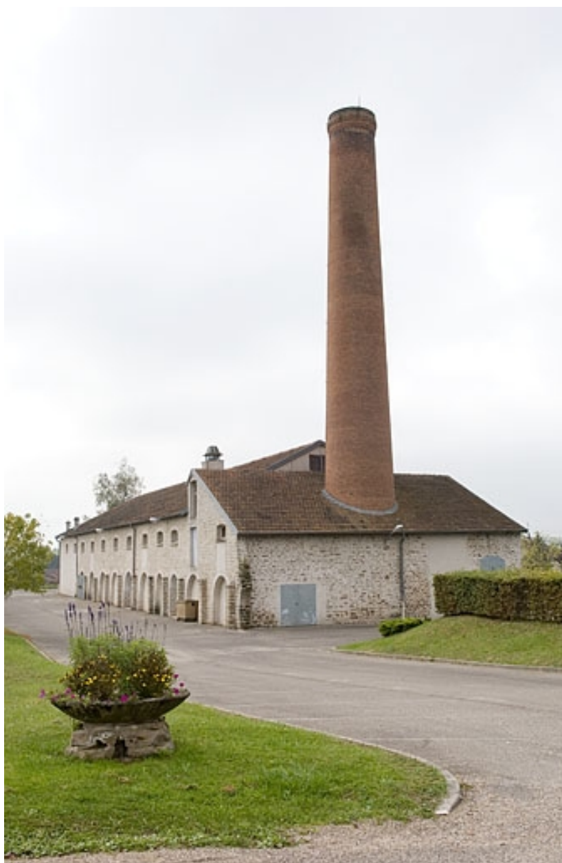
Vue depuis l'est (cadrage vertical).
