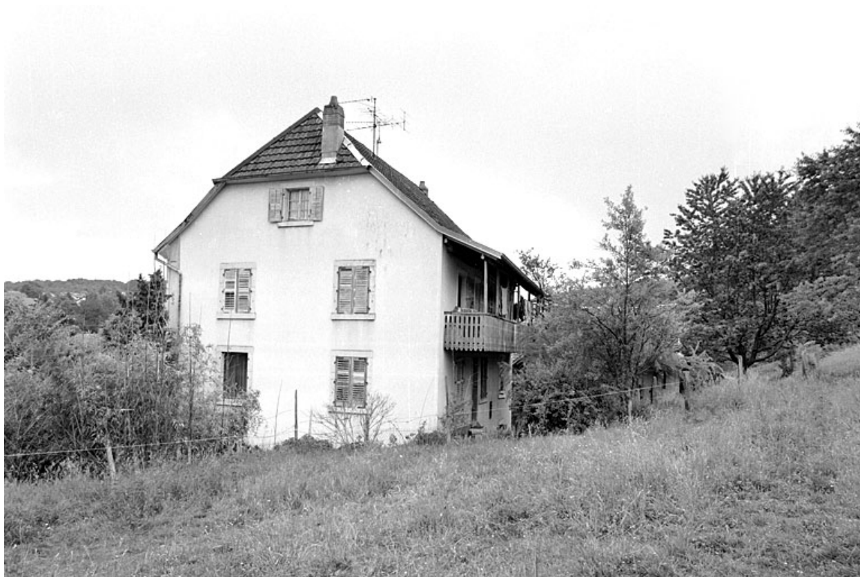
Logement patronal depuis l'ouest.
