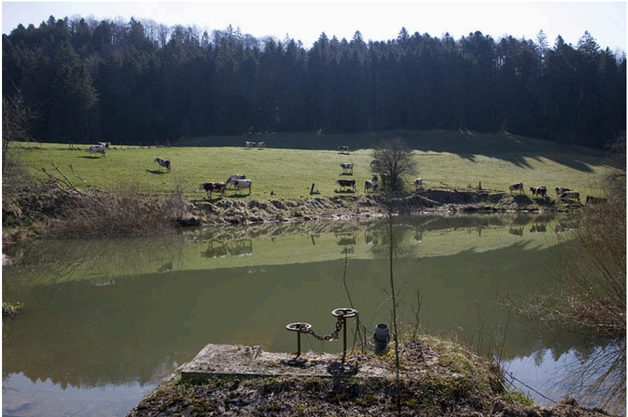
Réservoir : vue d'ensemble, depuis l'ouest.
