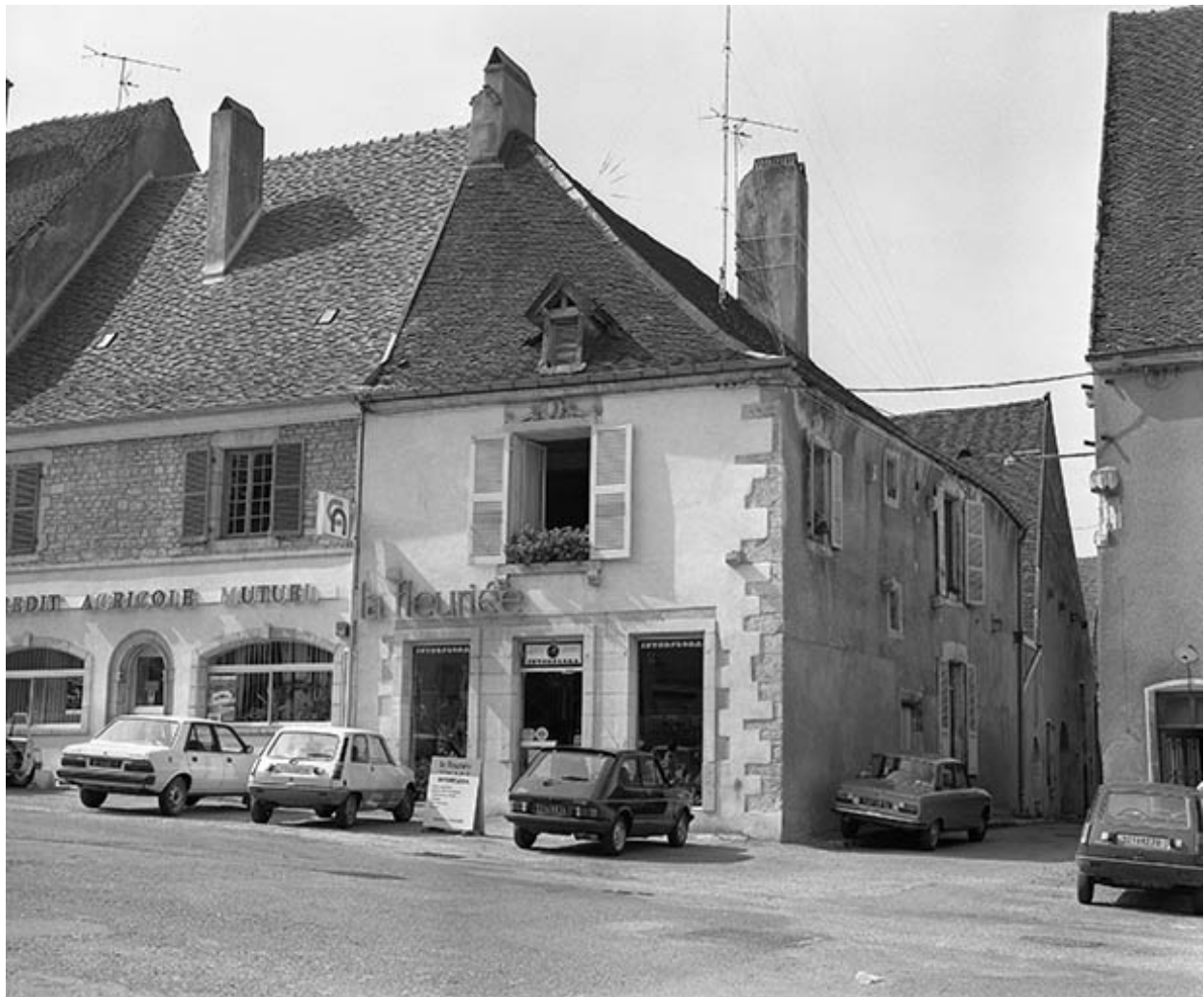
Ferme située rue Notre-Dame : vue d'ensemble.
