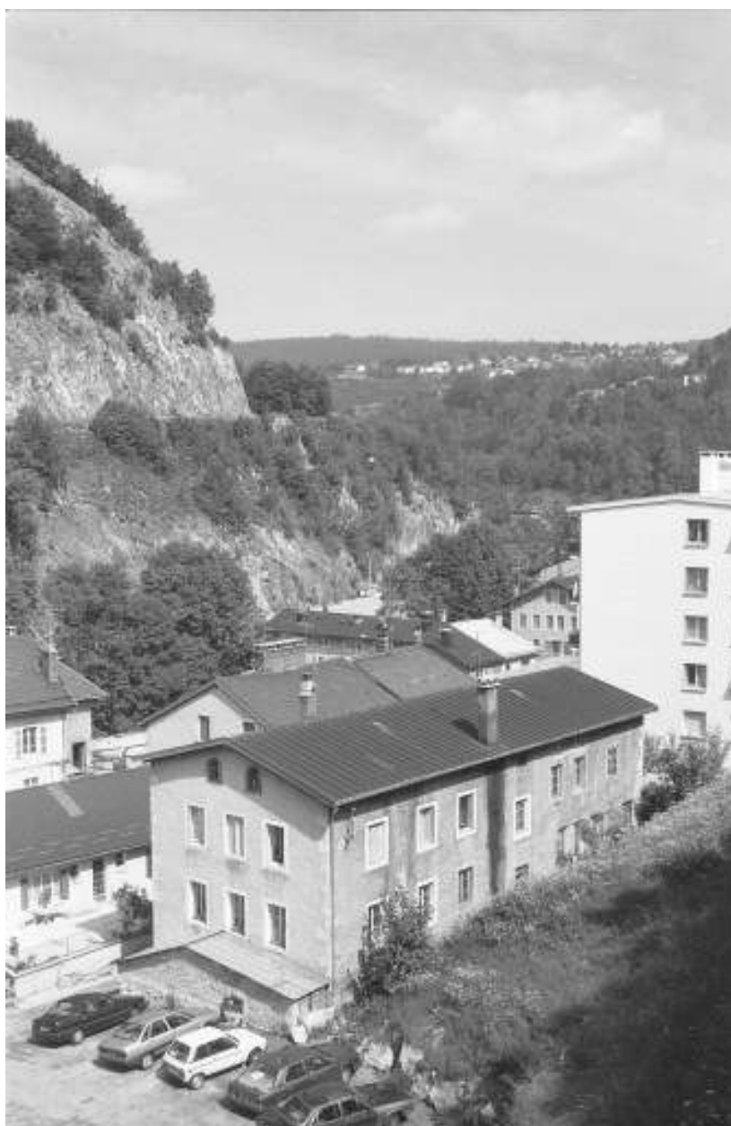
Vue d'ensemble plongeante depuis l'est.
