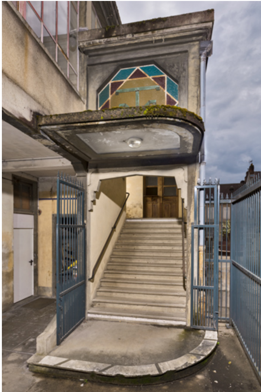
Cage de l'escalier principal.
