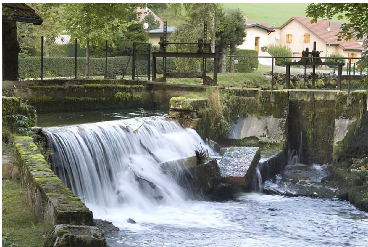
Canal d'amenée : vannes et déversoir.
