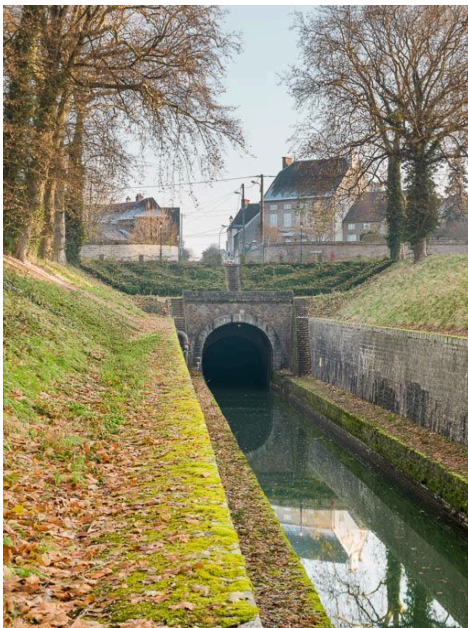
Sortie du tunnel côté Pouilly.
