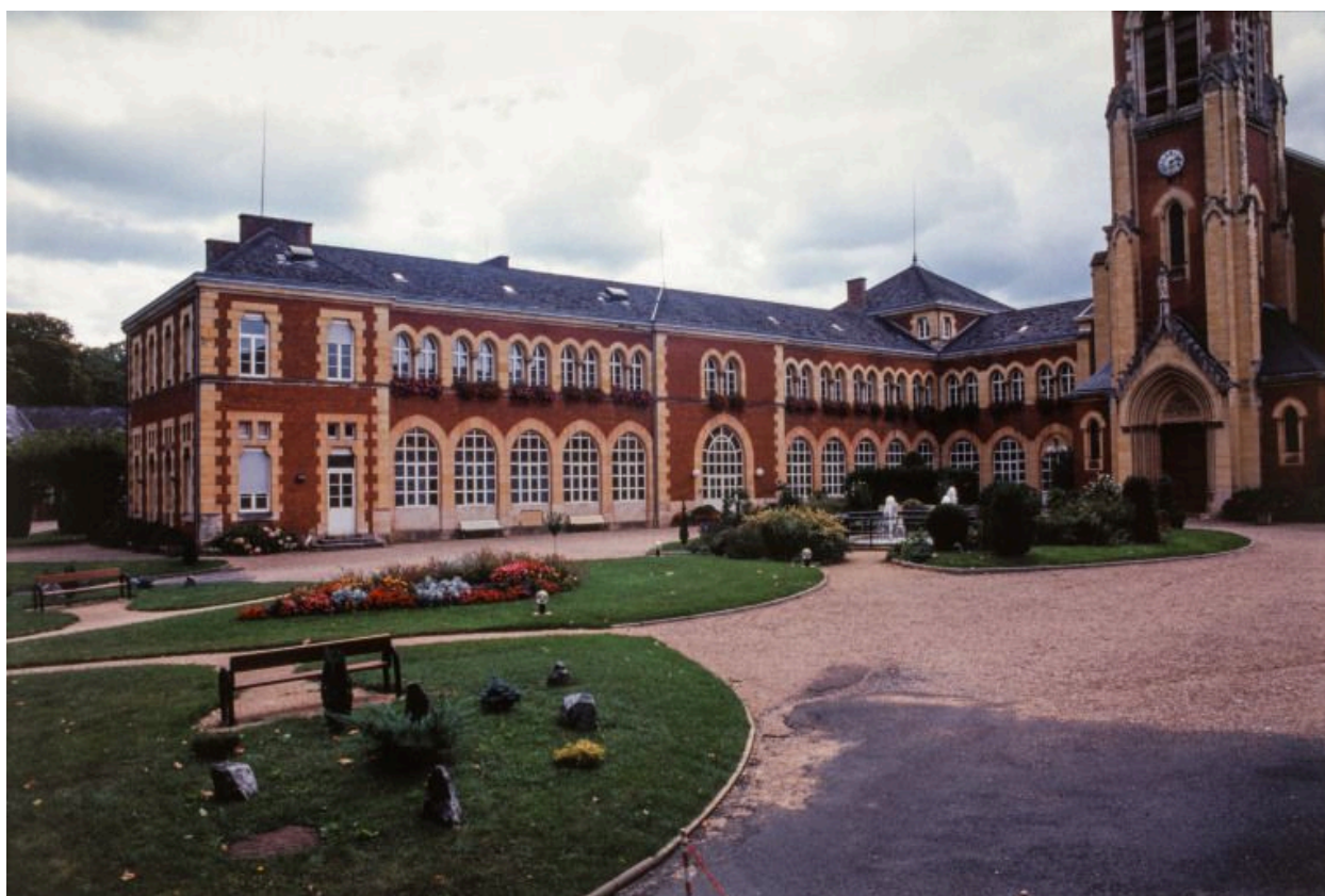
Aile gauche, façade antérieure.
