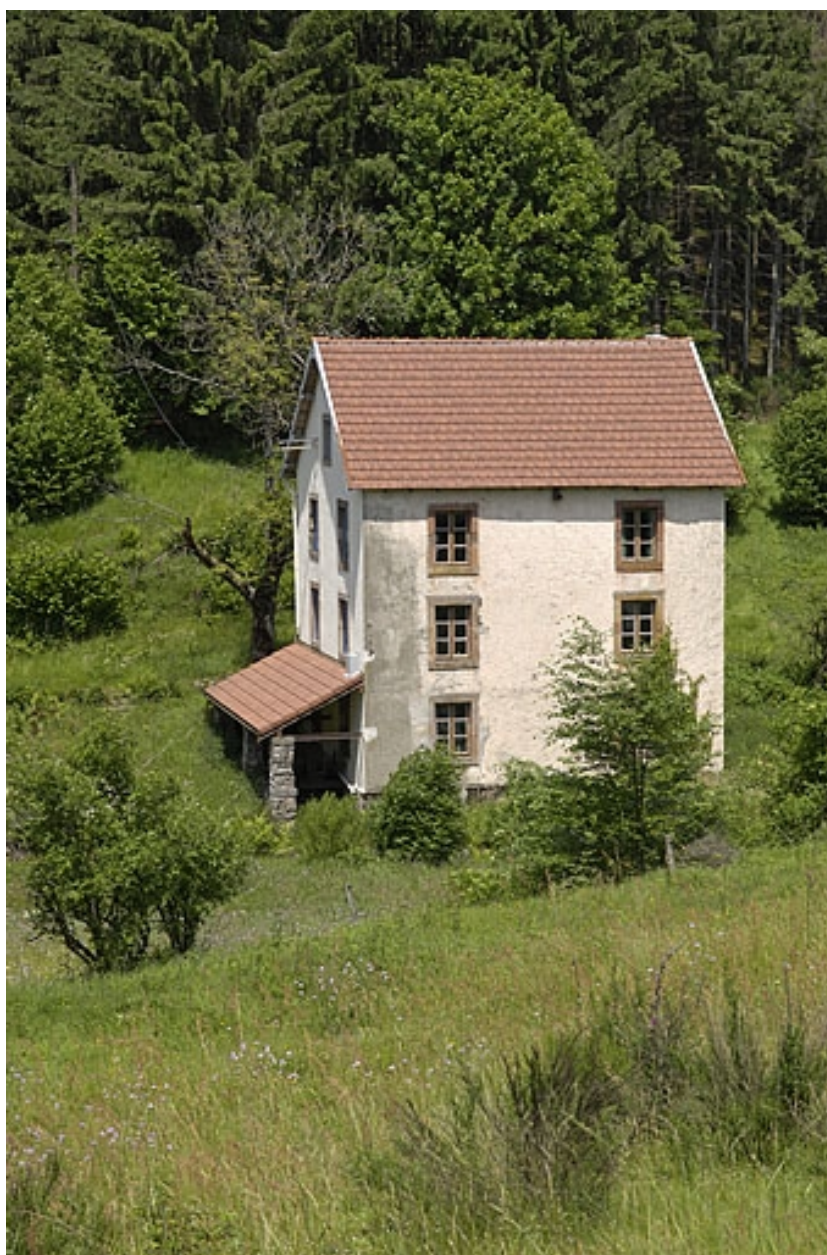
Façade sud du moulin.
