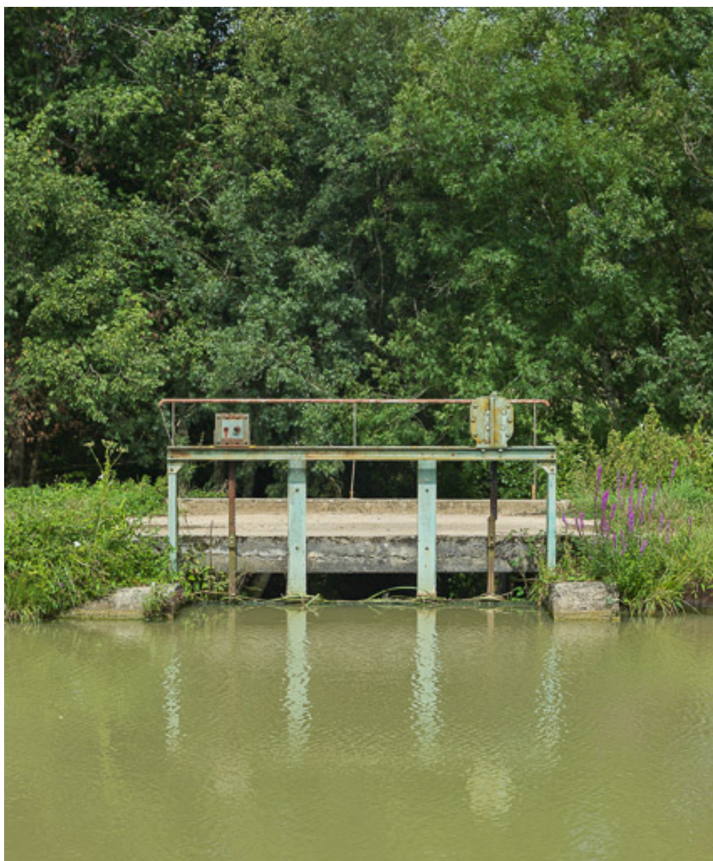
Vue du déversoir.
