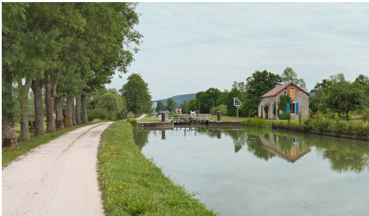
Vue d'ensemble du site d'écluse.
