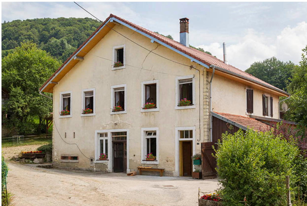
Façades antérieure et latérale droite.
