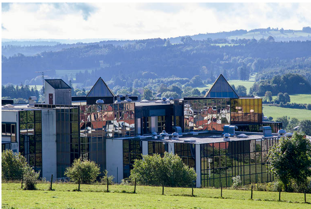
Emboîtement de volumes, vu du nord-ouest.
