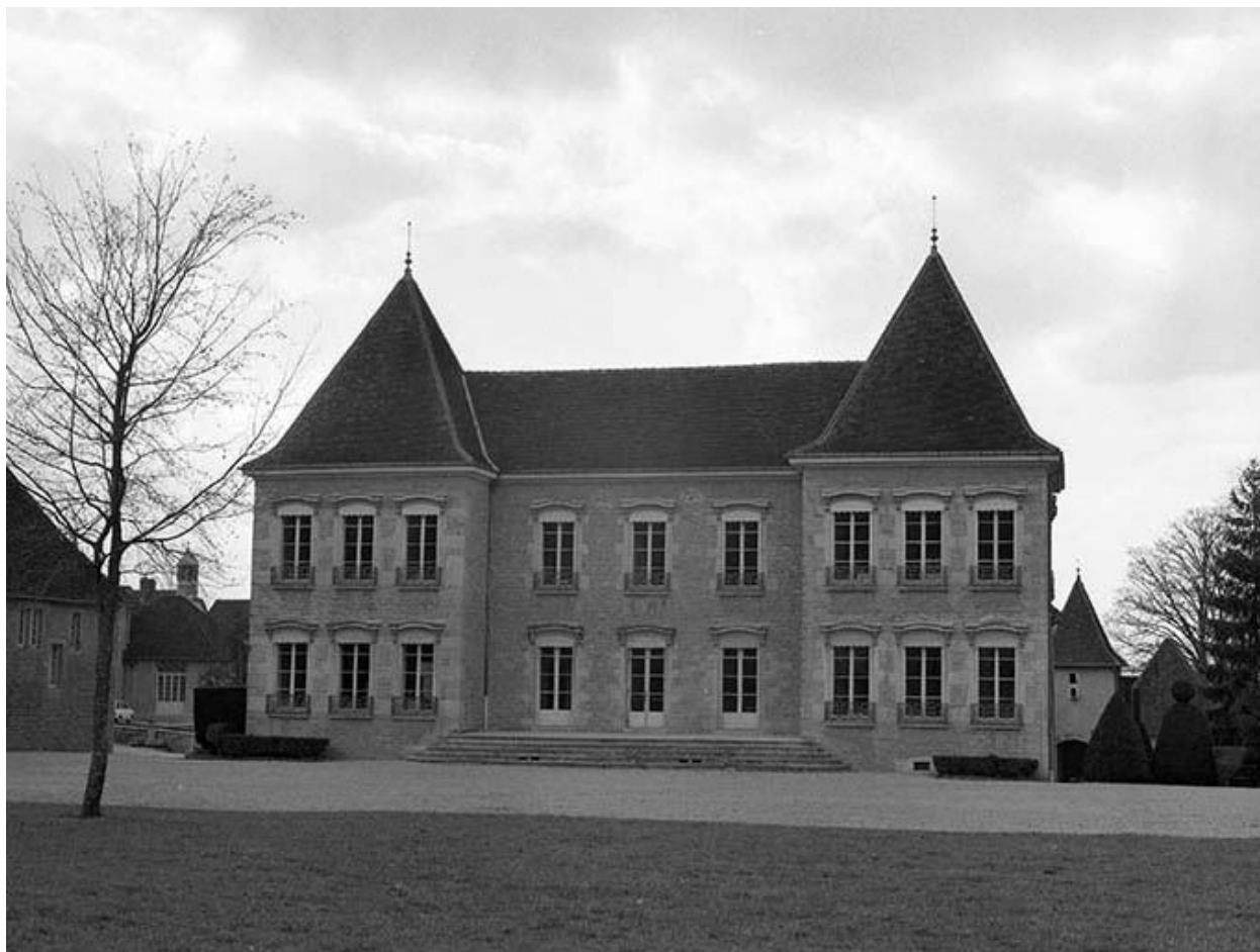
Corps du logis principal, façade principale.
