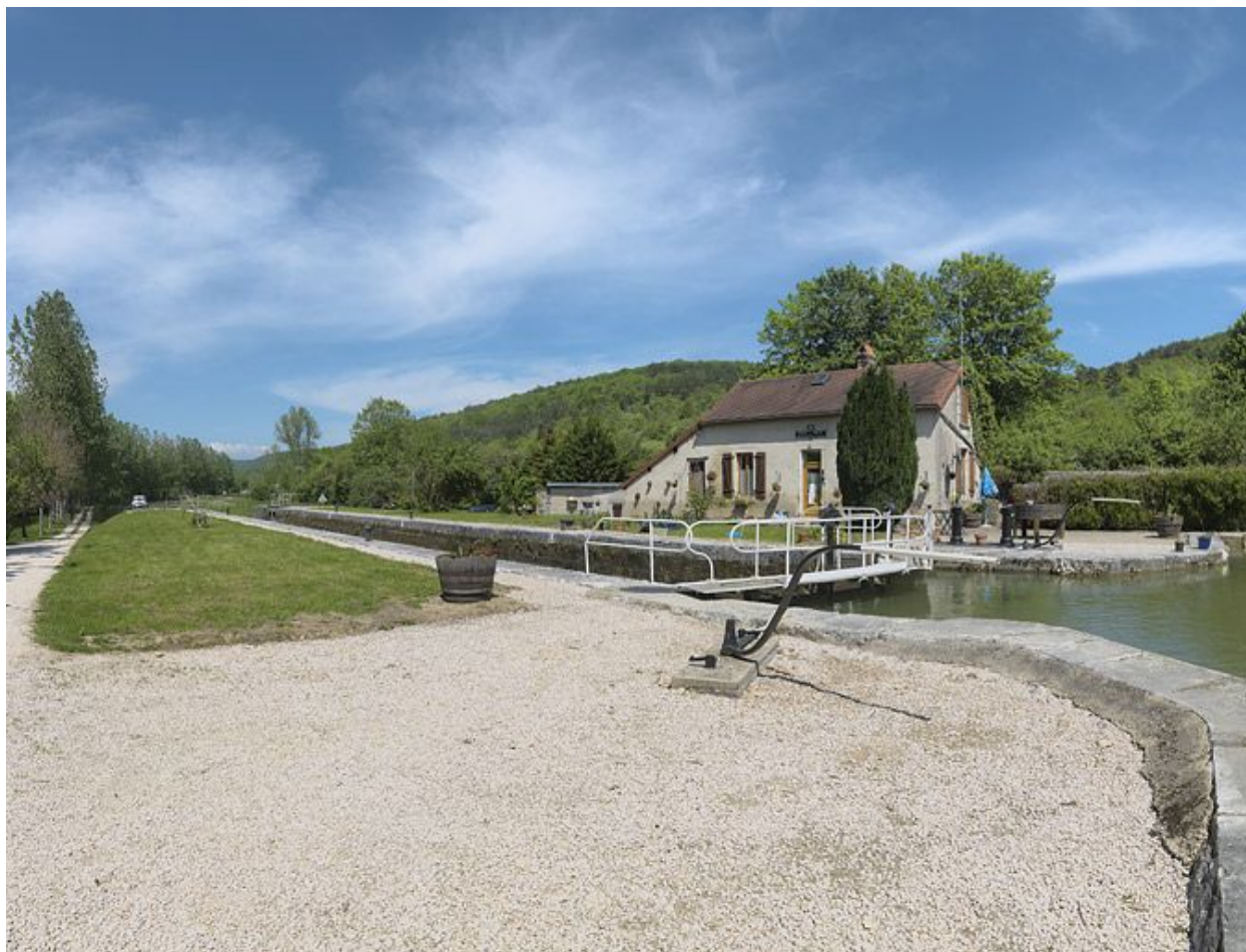
Vue d'ensemble de l'amont.
