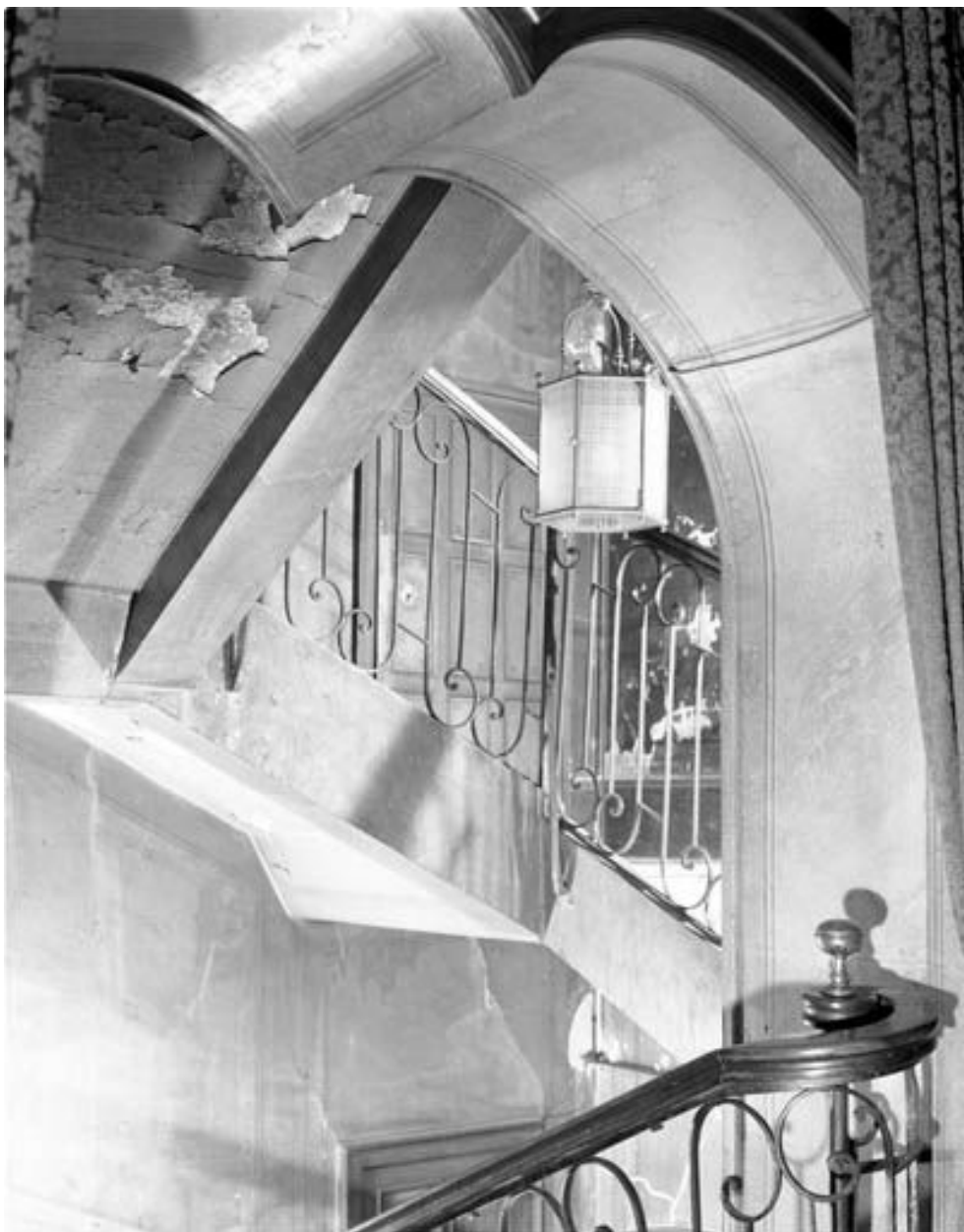
Logement patronal : cage d'escalier.
