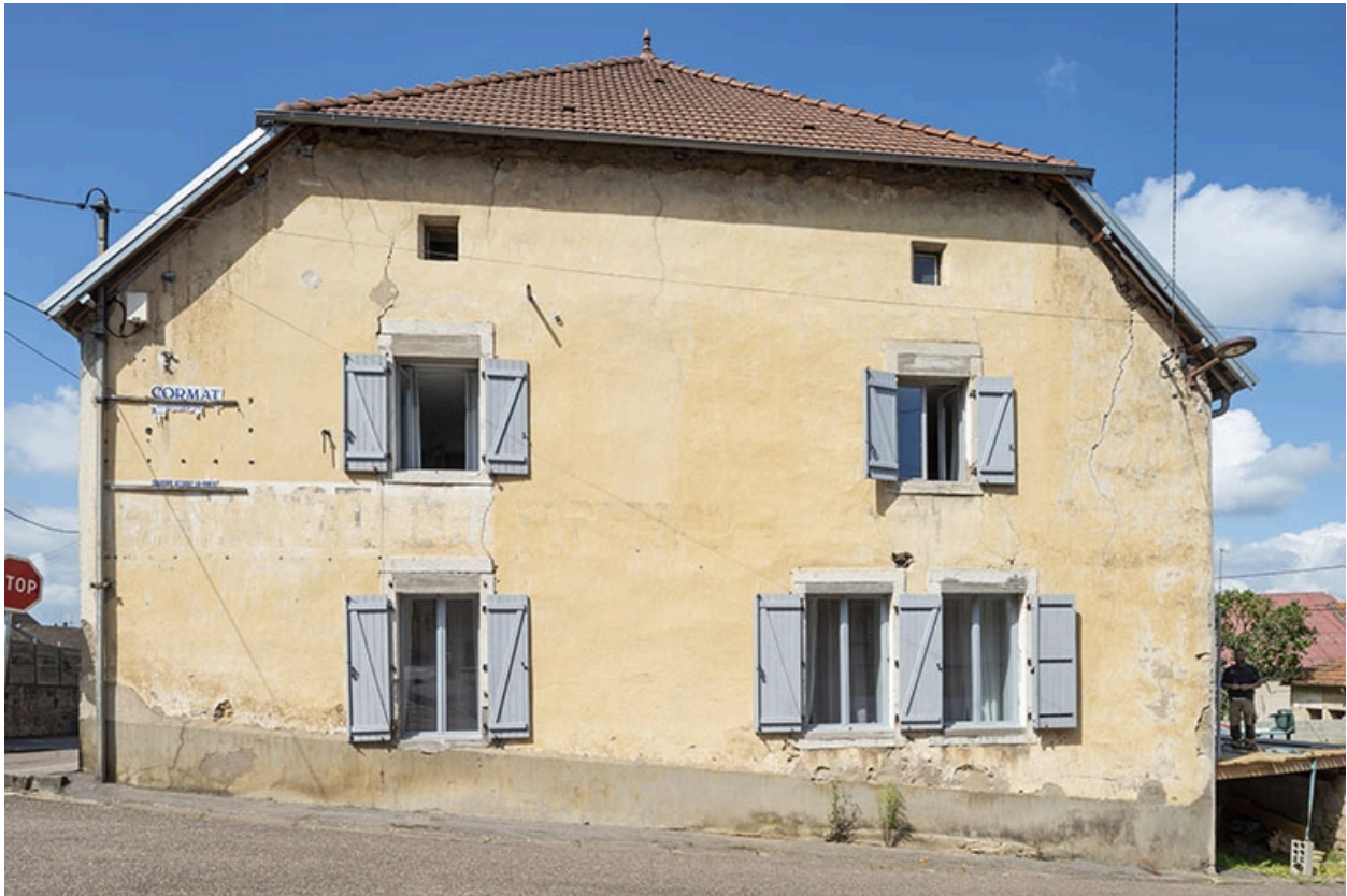
Mur pignon de la ferme, depuis la rue de la Pêcherie.
