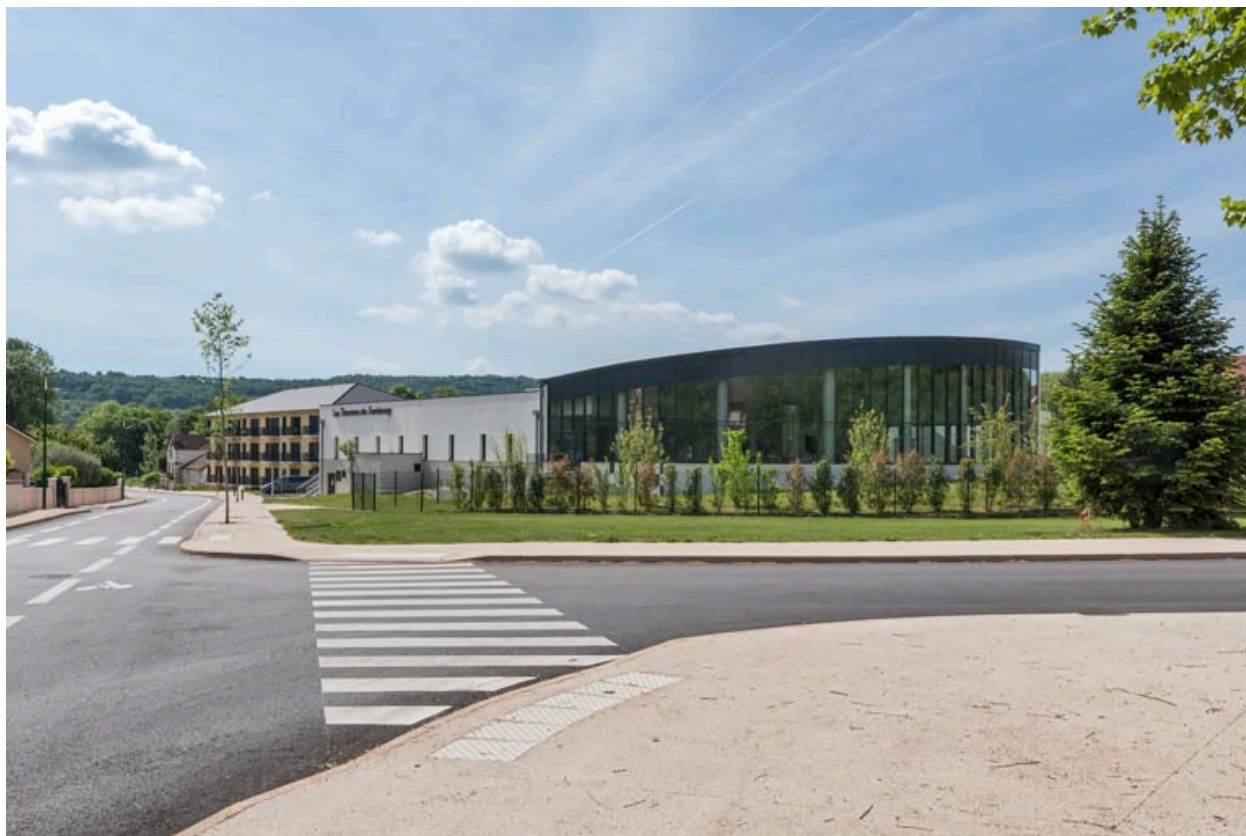
Centre thermal de 2021.
