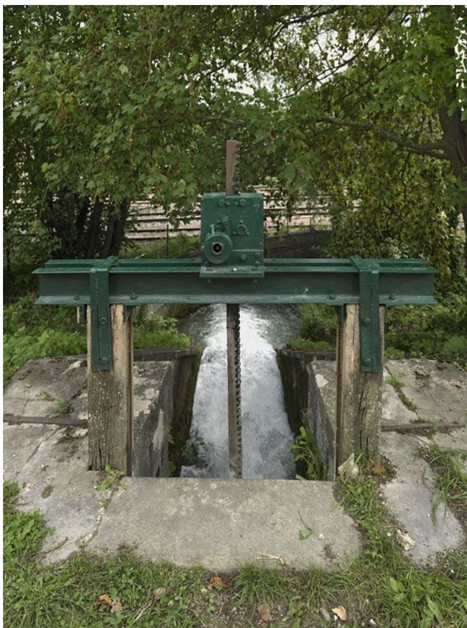
Détail de la vanne du déversoir de fond rive gauche.
