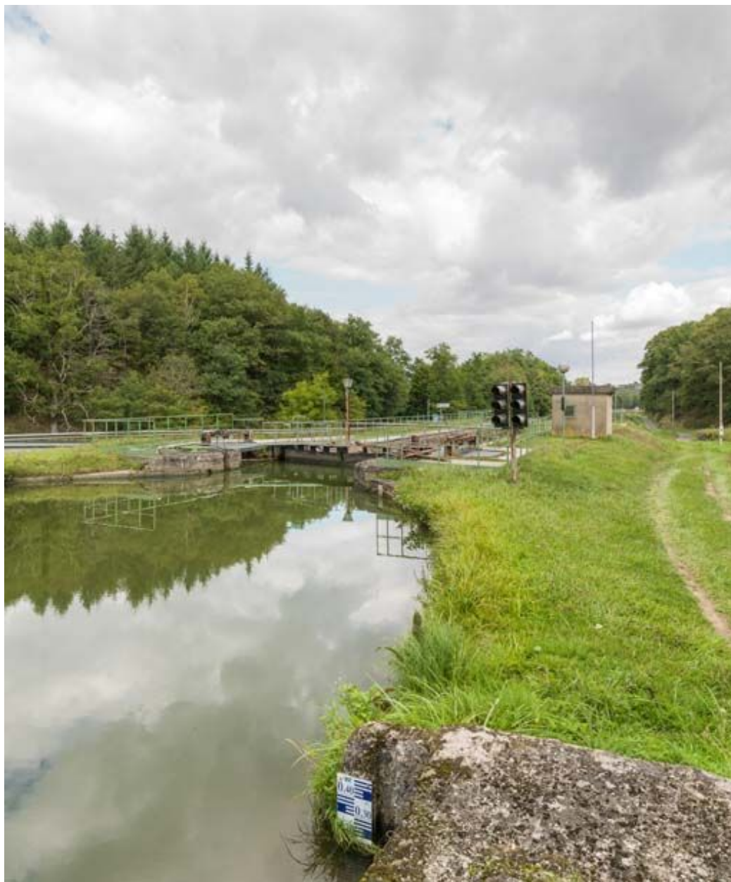
Vue d'ensemble du site d'écluse.
