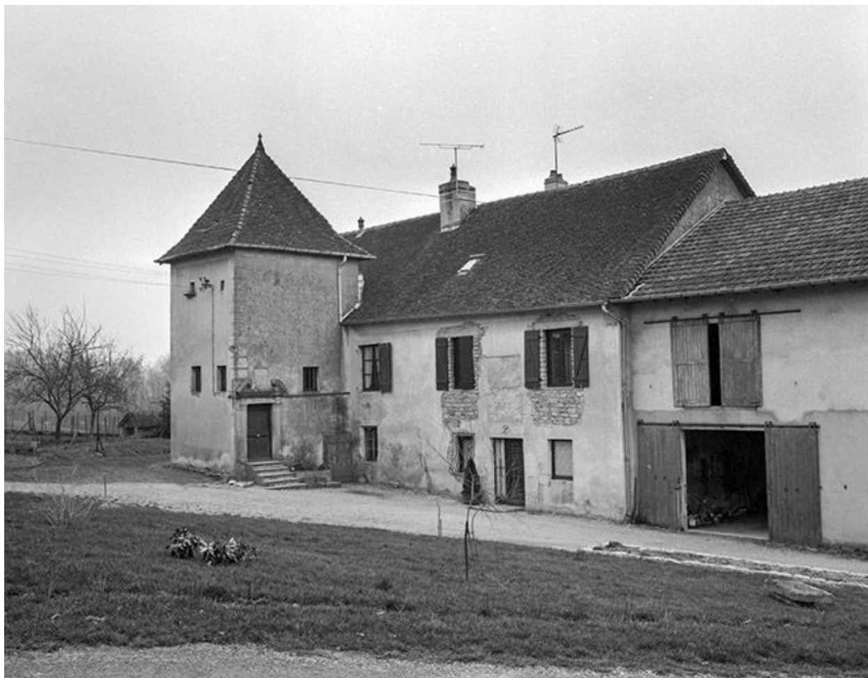
Demeure dite Grange Mercier ou Ferme de l'hôpital, située au lieudit L'Hôpital.
