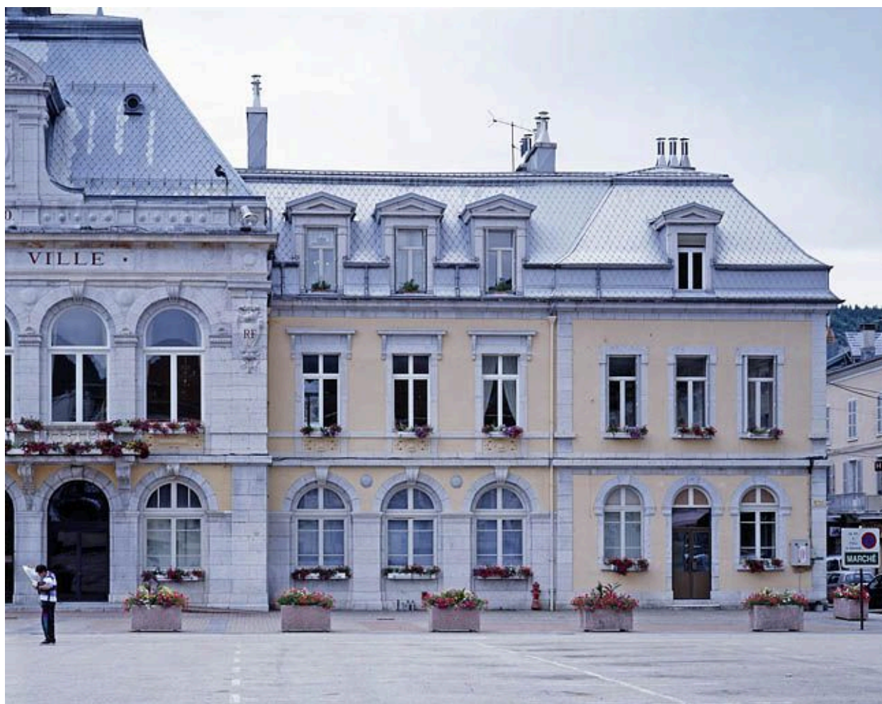
Elévation antérieure : partie droite.
