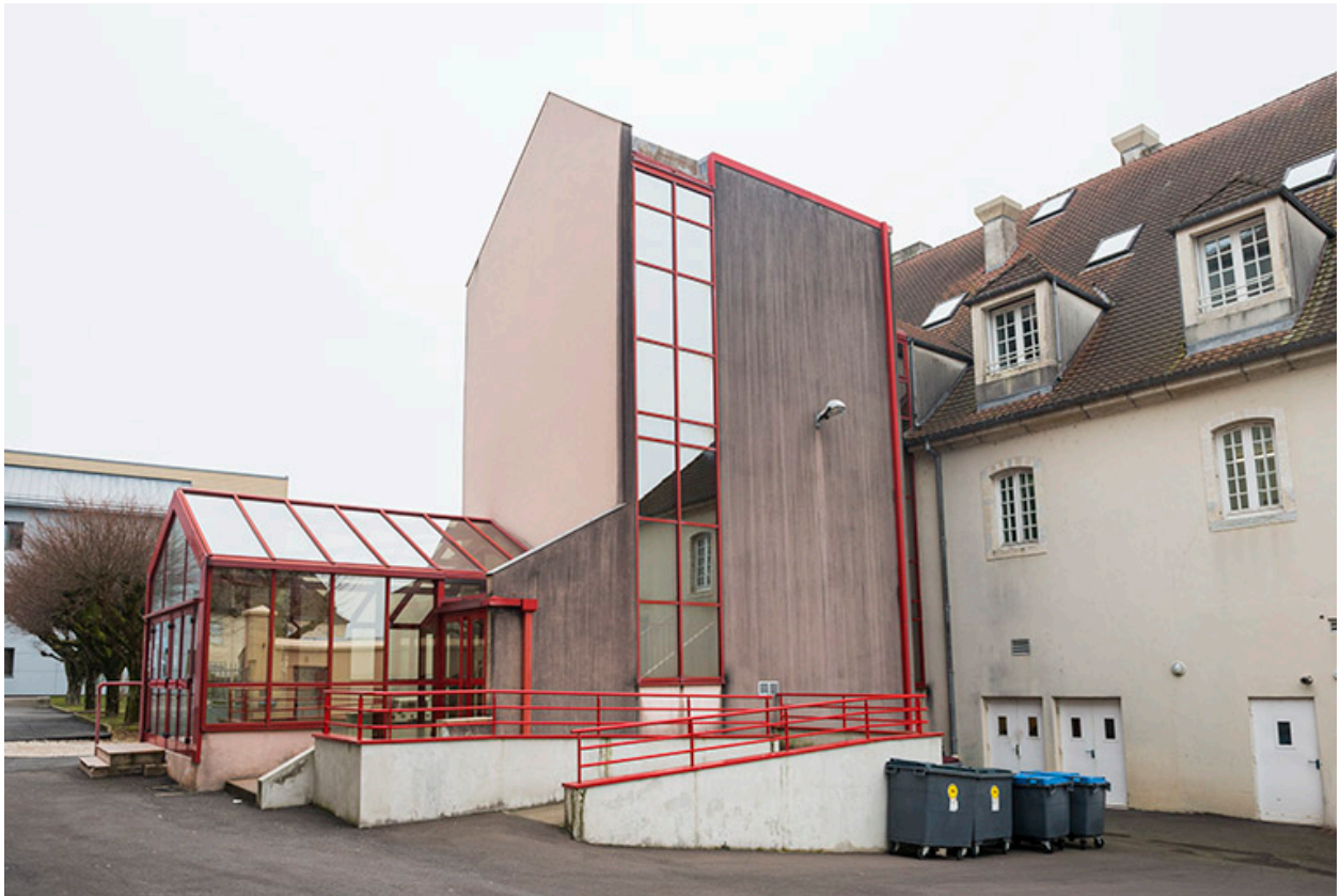
Extension de l'accueil sur la façade nord-ouest du bâtiment de cantine et internat de filles.
