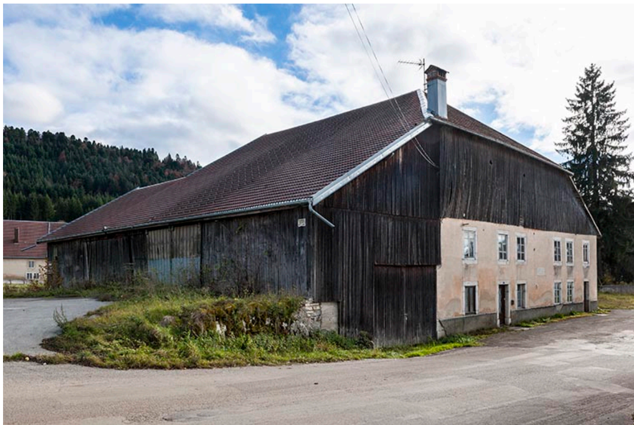
Vue depuis le nord.
