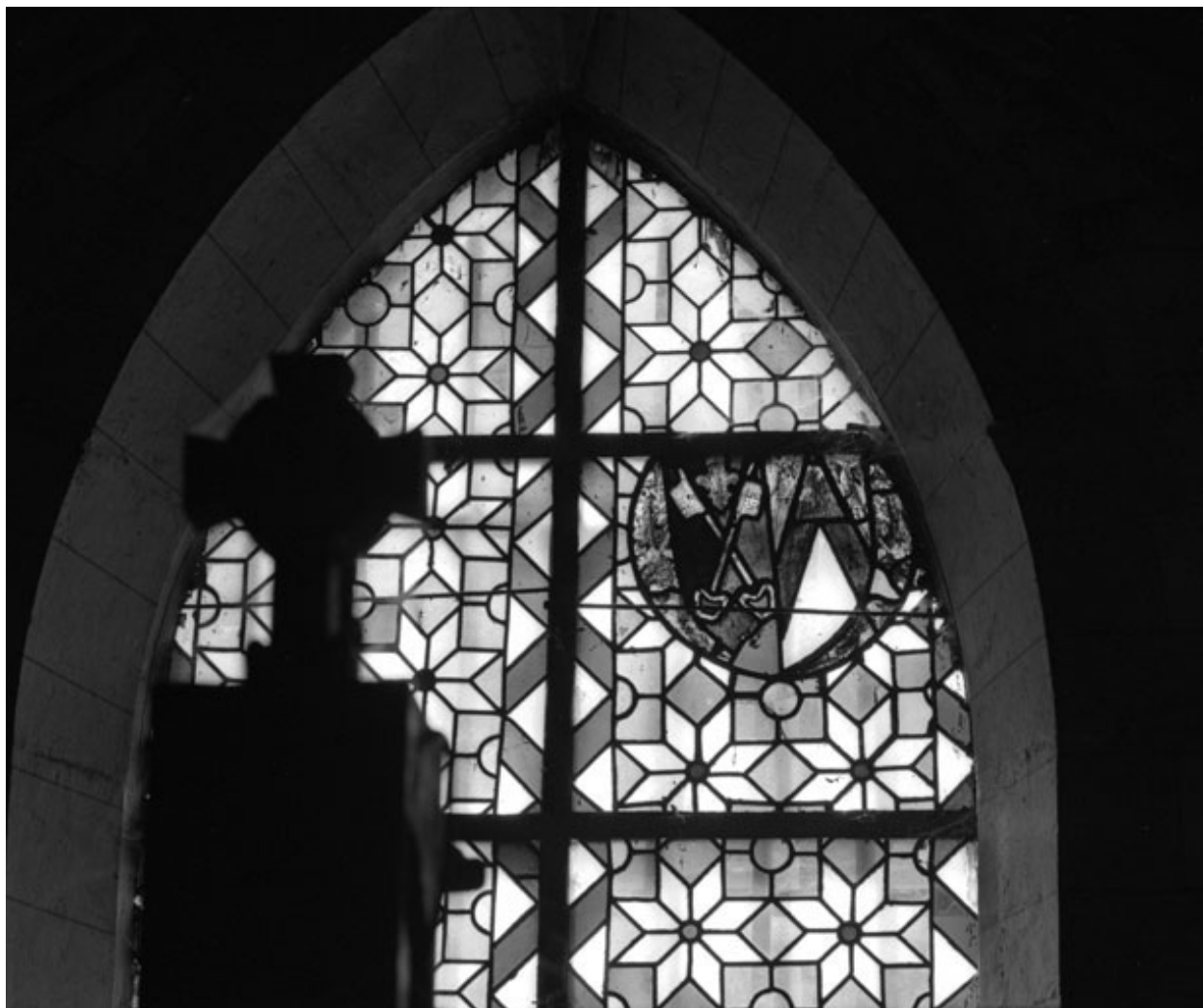
Baie 8 : partie supérieure.
