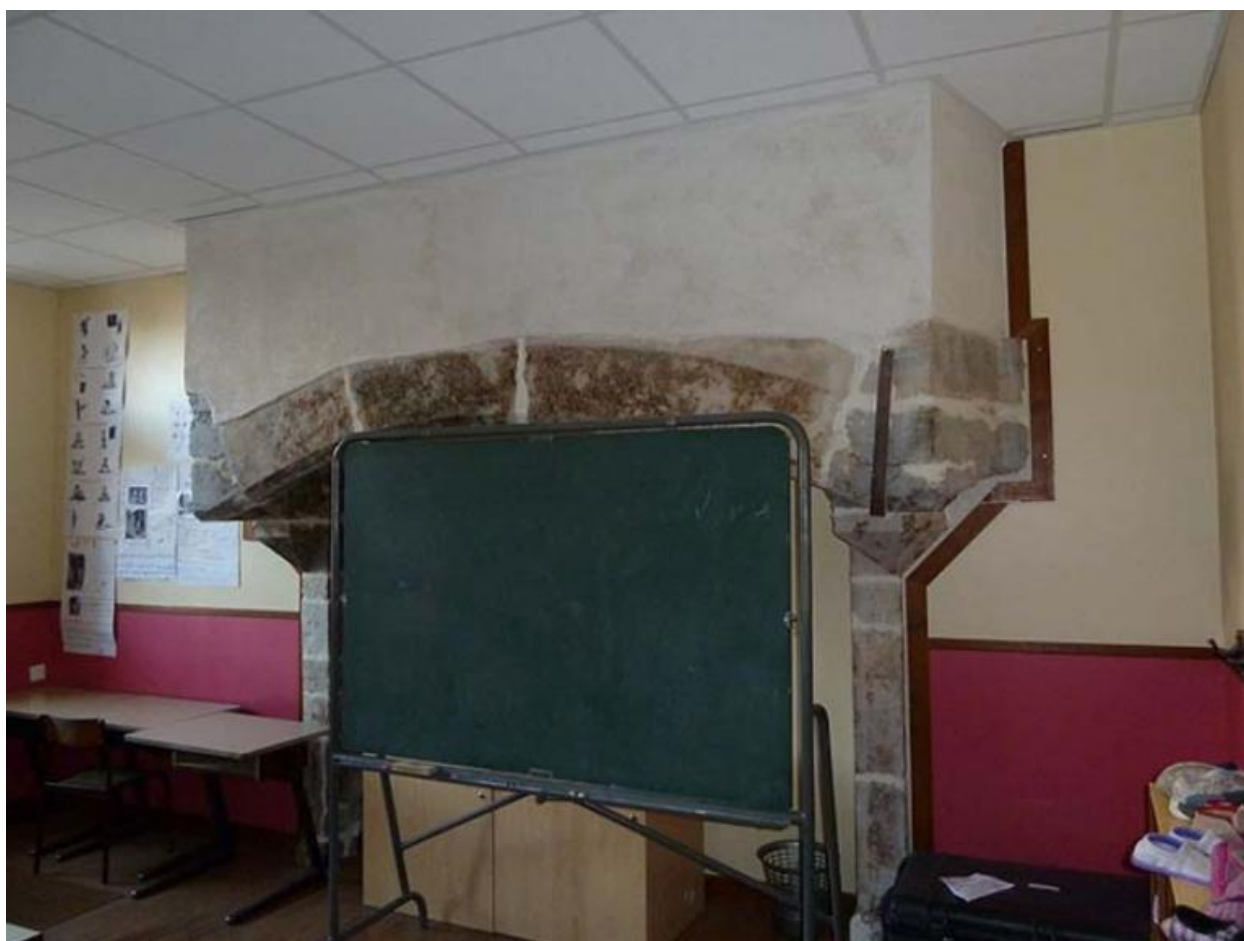
Cheminée monumentale, adossée à la précédente
