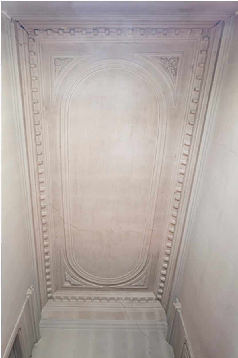
Plafond de la cage d'escalier.
