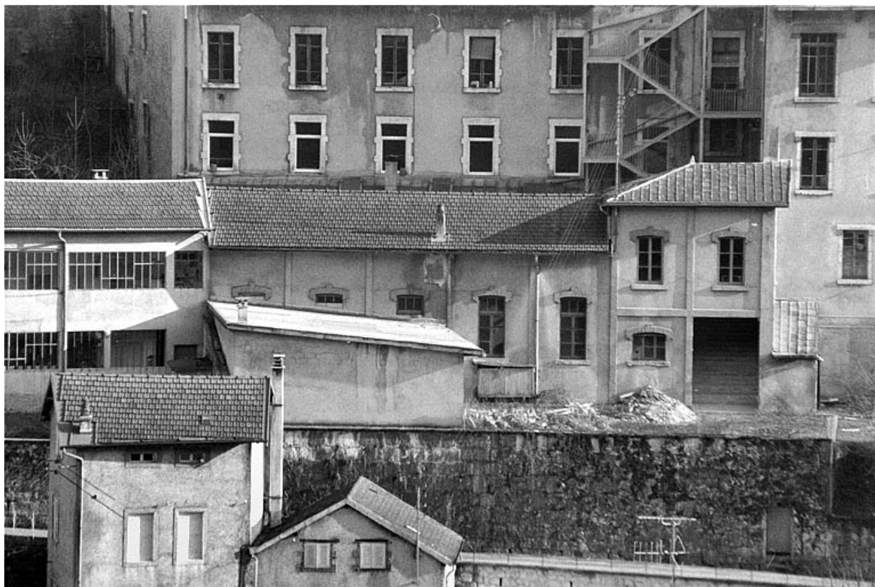
Gymnase : façade sur la Bienne.
