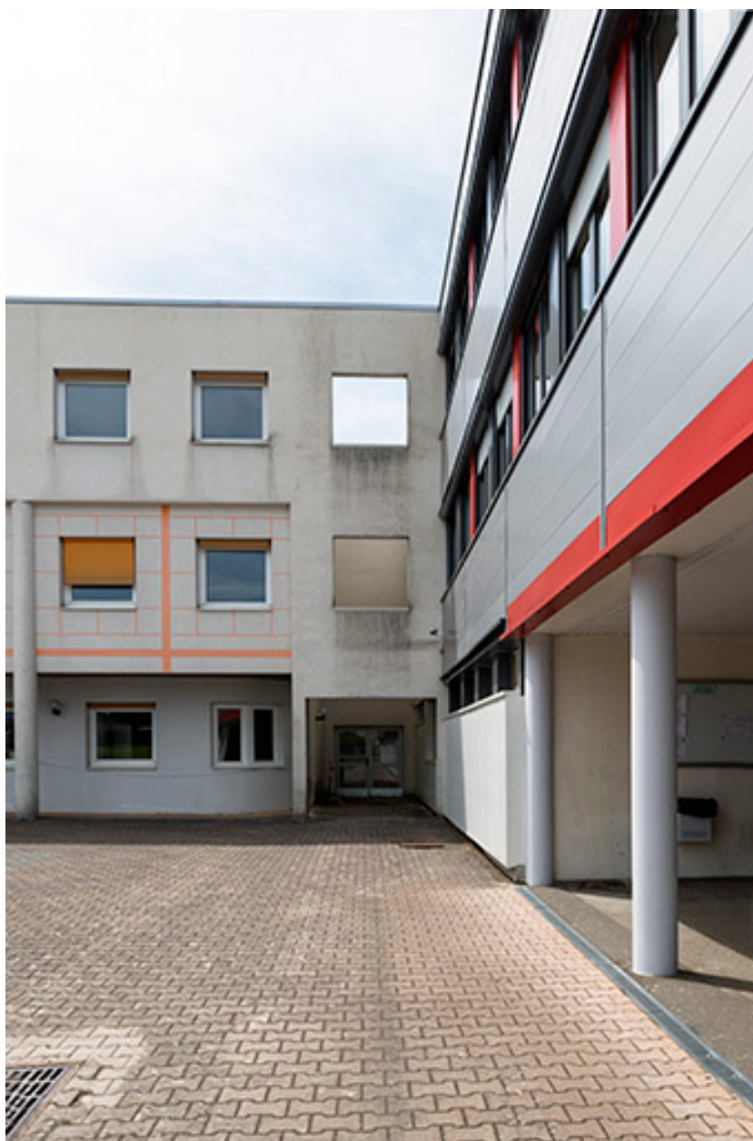
Angle intérieur nord-ouest de la cour.
