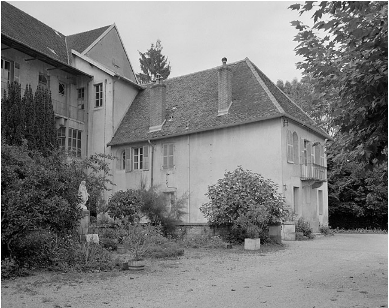
Façade latérale gauche du bâtiment A.
