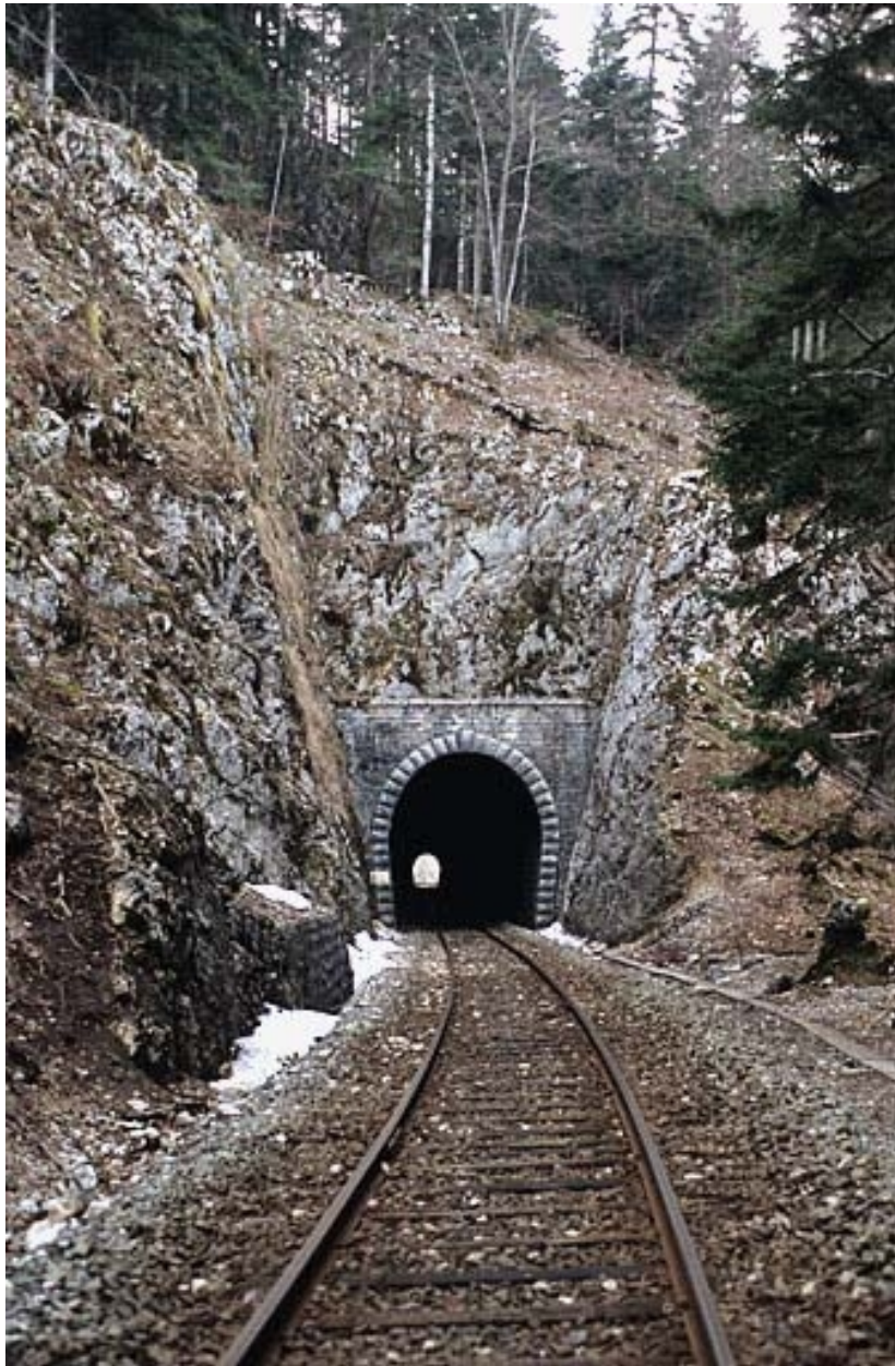
Tunnel : tête côté La Cluse.
