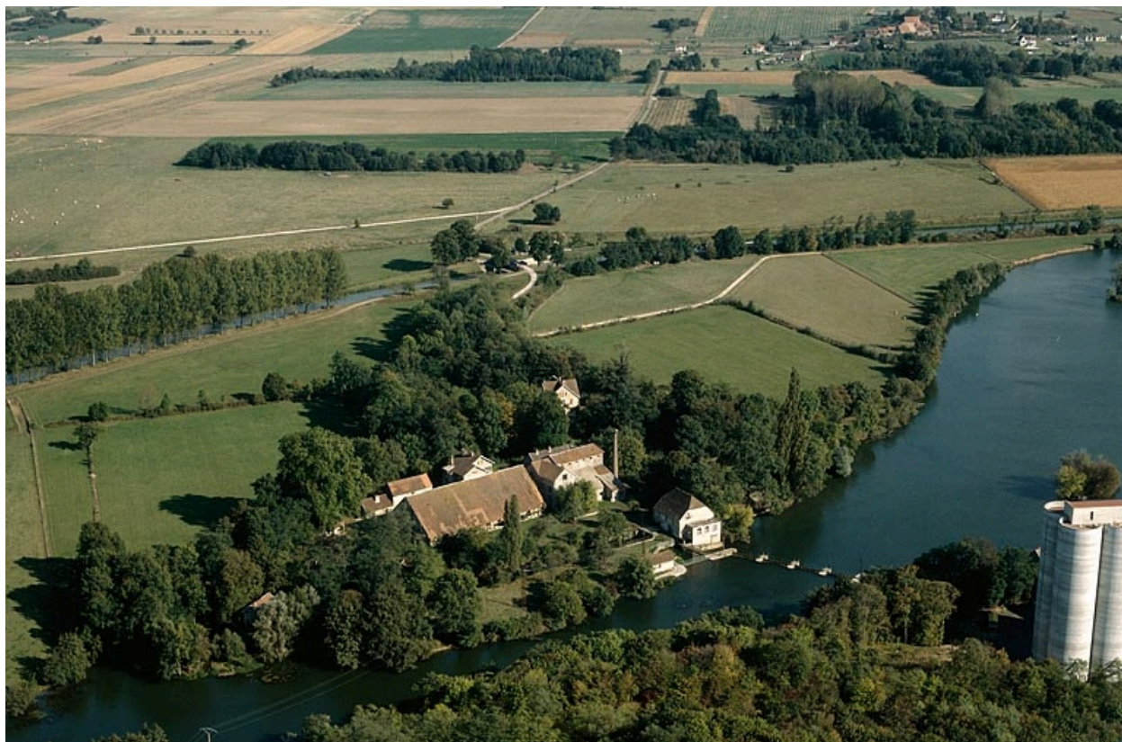
Vue aérienne depuis le nord-ouest en 1989.
