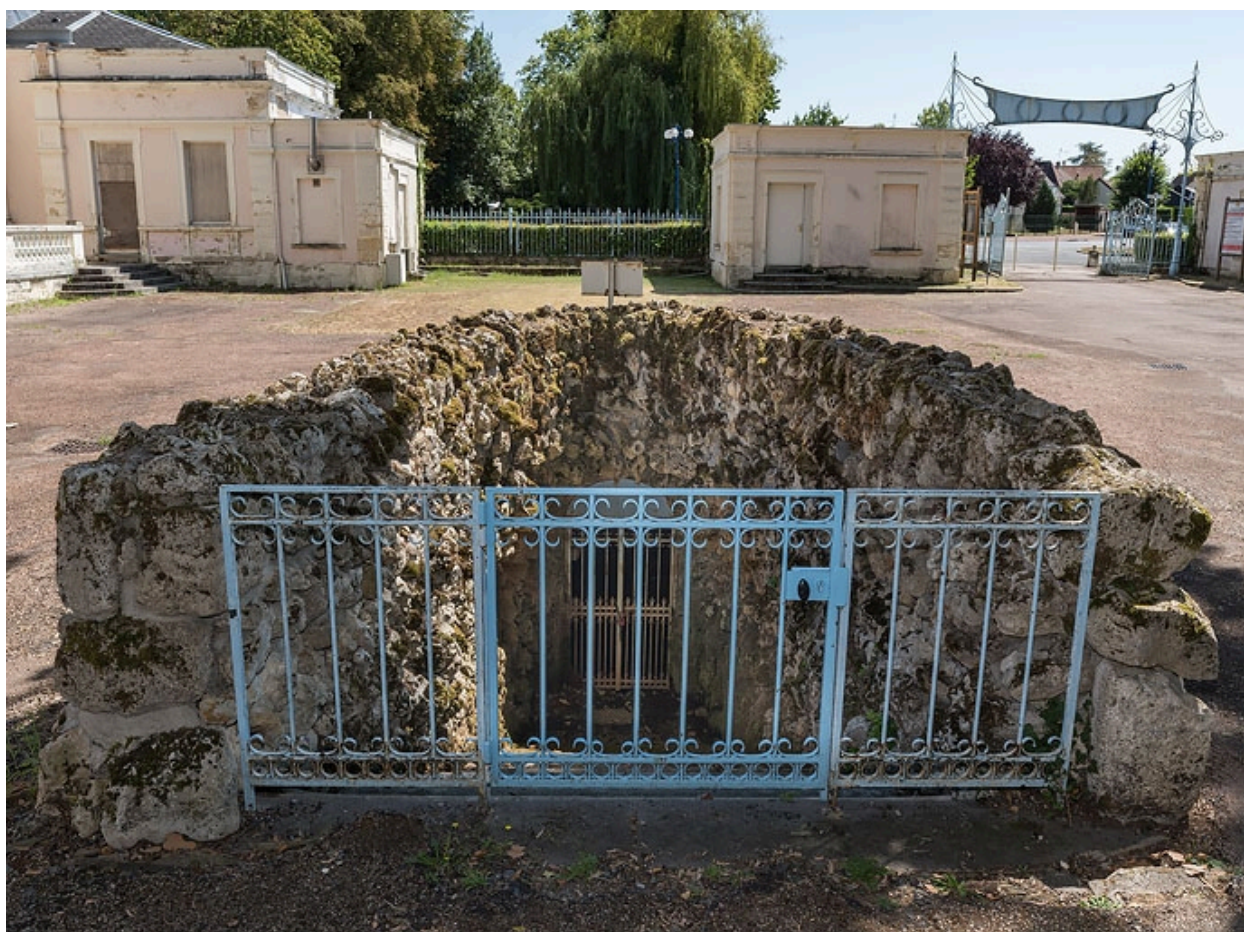
Escalier de la source, détail.
