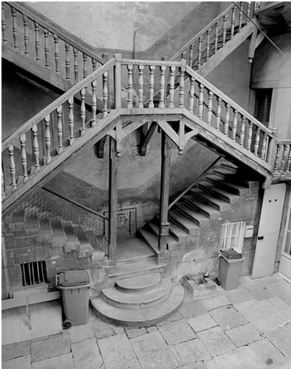
Escalier dans la cour.
