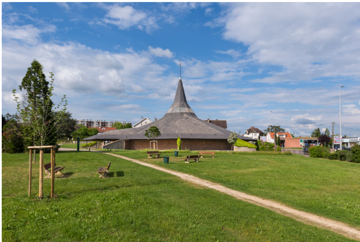
Vue depuis le sud.
