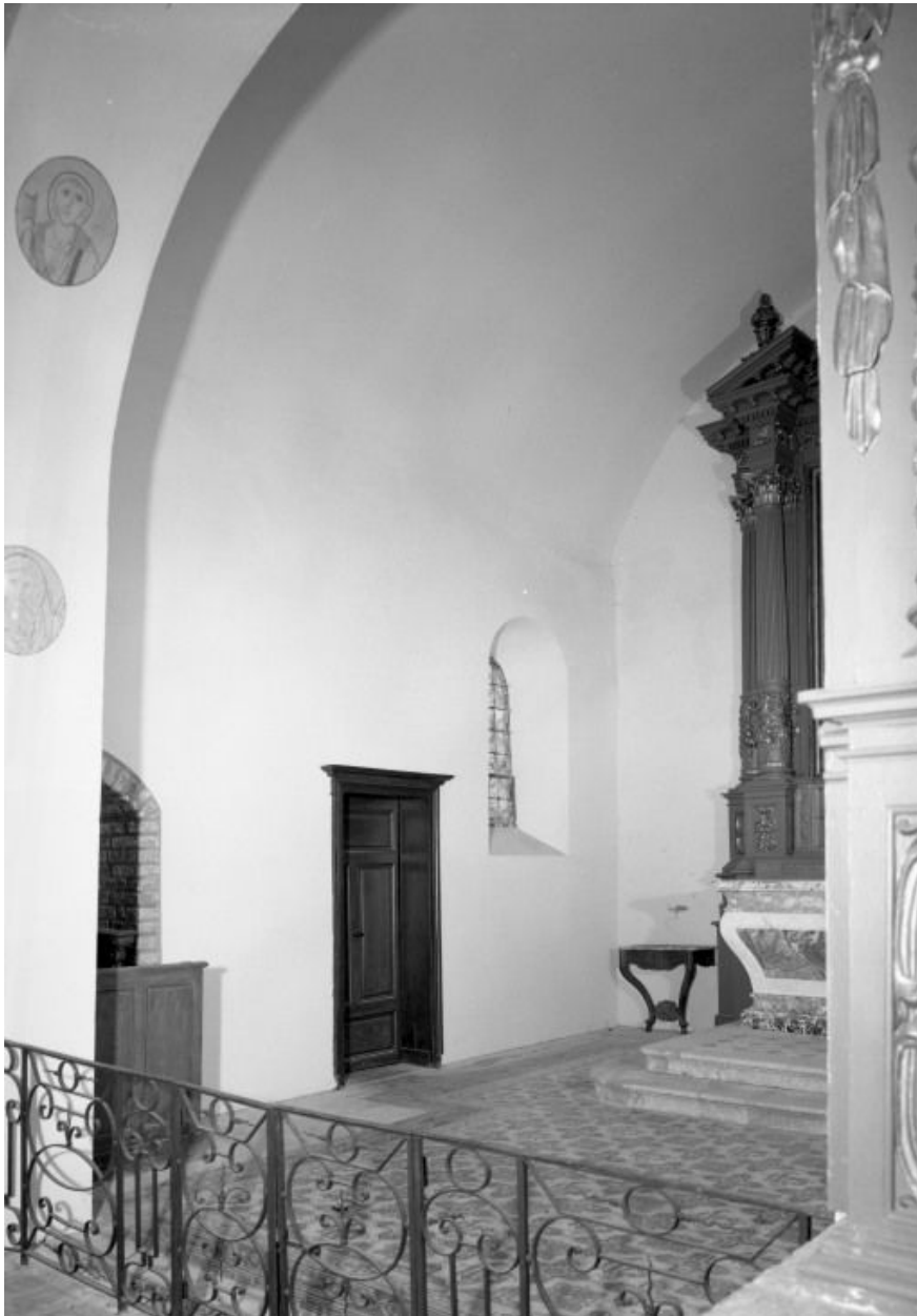
Choeur, mur gauche
