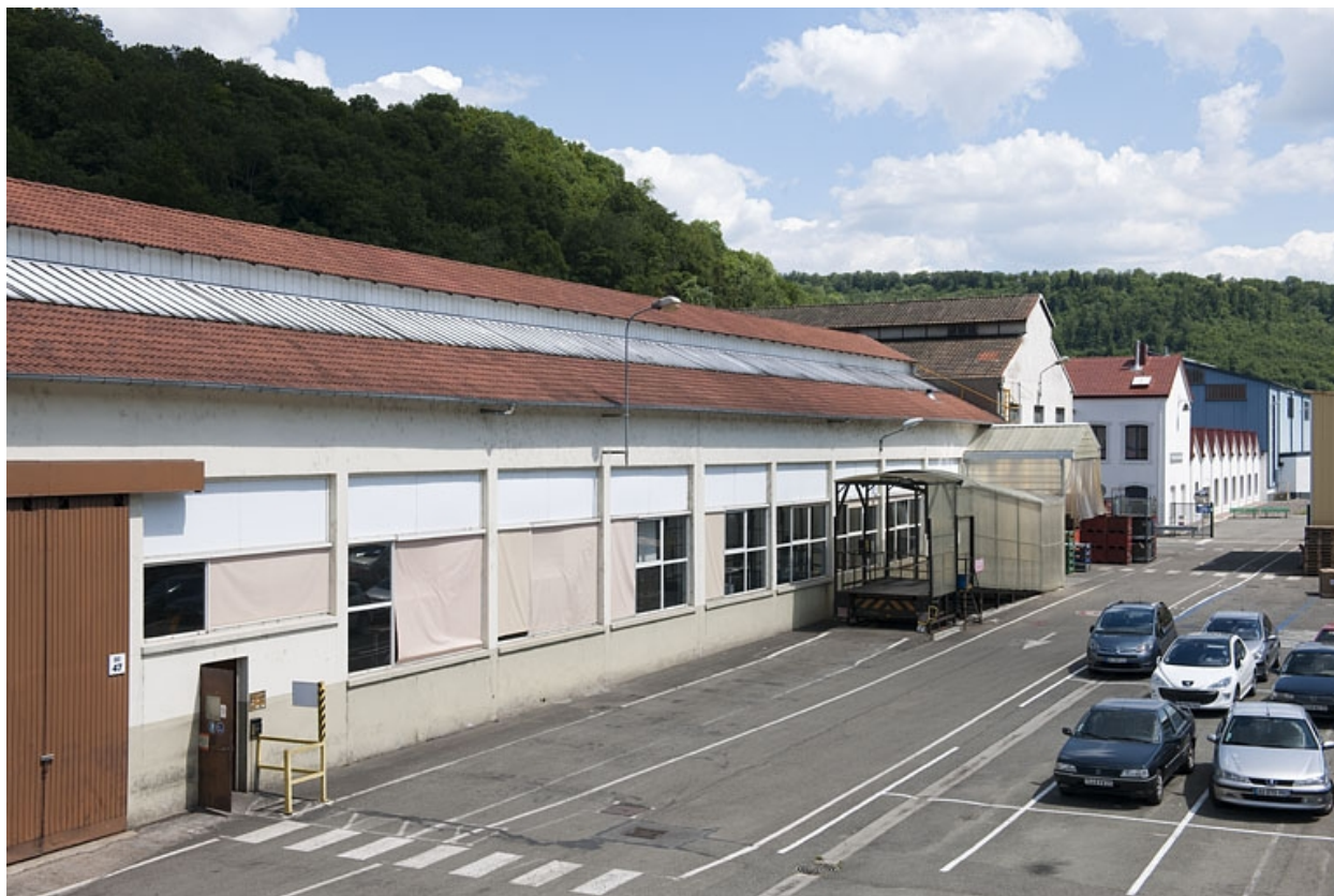
Magasin industriel. Façade ouest.
