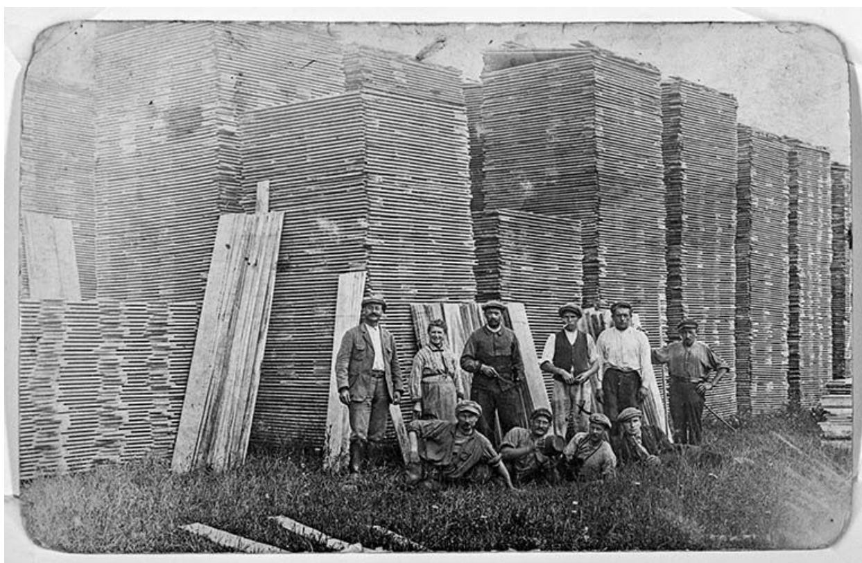
La scierie Beldigot à Asnois, au bord du canal. Photographie ancienne.
